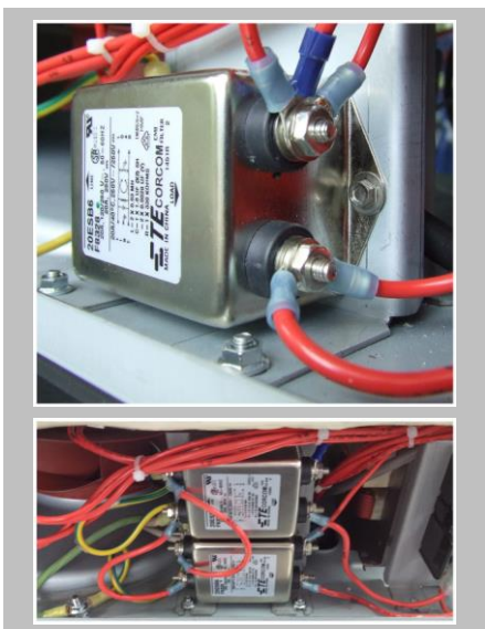
Superior: una unidad de filtro de EMC (variante de 1000 W e2s) Inferior: dos unidades de filtro de EMC (variante de 2000 W e2s)
